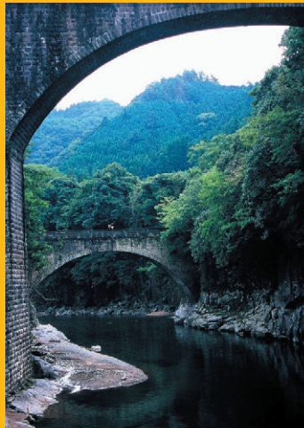
轟橋から見た出逢橋
